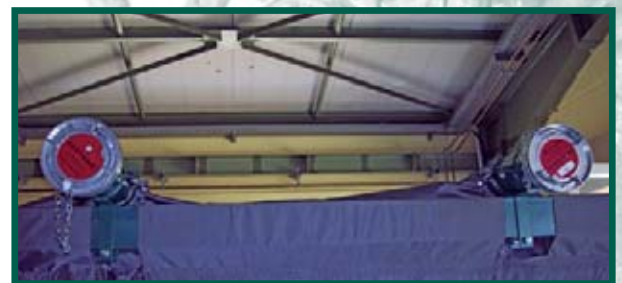
Bei Siloabmessungen ab 2,54 x 2,54 m sind die Holzpelletsilos mit zwei Füllstutzen ausgerüstet.
