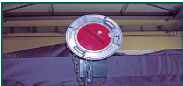
Bei Siloabmessungen bis 2,23 x 2,23 m sind die Holzpelletsilos mit einem Füllstutzen ausgerüstet.
